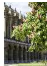
ResMü.I, Nordfassade (Festsaalbau), DI006181, BSV
