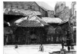
ResMü.I, Grottenhof, Zerstörungszustand 1953/1954, DE000965, BSV-
