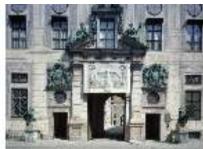
ResMü.I, Westfassade, südliches Portal, DE000736, BSV-
