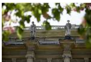
ResMü.I, Nordfassade (Festsaalbau), Skulpturen, DI006190, BSV
