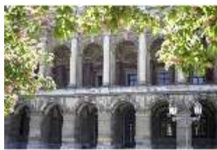
ResMü.I, Nordfassade (Festsaalbau), DI006189, BSV
