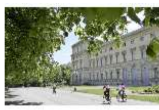
ResMü.I, Nordfassade (Festsaalbau), DI006169, BSV
